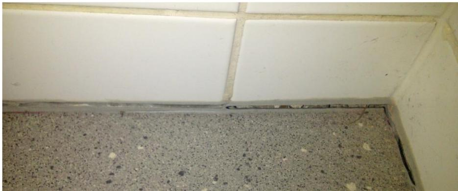
Anhand dieses Beispiels ist zu erkennen, dass die Fuge fachlich falsch gemacht worden ist. Das Silikon wurde aufgespritzt, es rinnt in sämtliche Zwischenräume und härtet dort aus. Leichte Bewegungen im Boden oder Wandbereich reichen dann aus, dass die Fuge abreißt. In solchen Fällen muss vorab mit einer Rundprofilschnurr die Hohlräume verschlossen werden, damit das Silikon dehnfähig bleibt und wie folgt sitzt:
