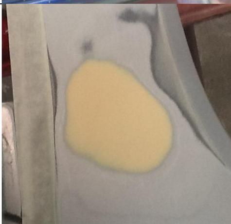
Durchgeschliffene Stellen mit einer Schicht **Invento-1-K-Primer UGR** abisolieren
